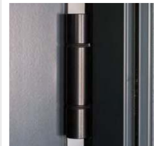
Sash & Jamb Hinge
